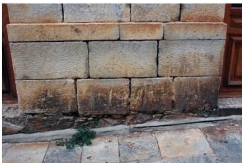
Εικ. 172 Αποκολλήσεις και απώλειες στα κονιάματα των αρμών
