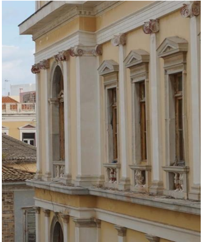
Εικ.26,27. Οι παραστάδες διαφορετικού ρυθμού ανά όροφο. Εμφανές είναι το υλικό κατασκευής των επικράνων και της μπαλουστράδας, λόγω απόλειας επιχρίσματος
