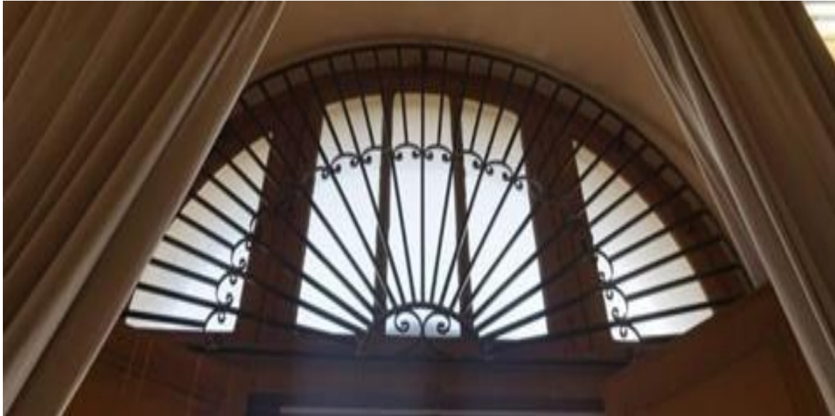
Εικ.35: Σφυρήλατη σιδεριά κουφώματος
