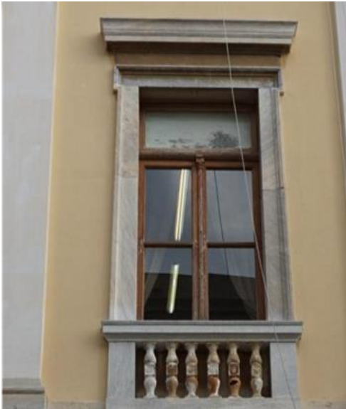
Εικ.41,Εικ.42: Τυπική διαμόρφωση ανοίγματος και κουφώματος α' ορόφου. Δεξιά το αυθεντικό σχέδιο Ziller. κουφώματος β' ορόφου που ακολουθεί το αρχικό σχέδιο
