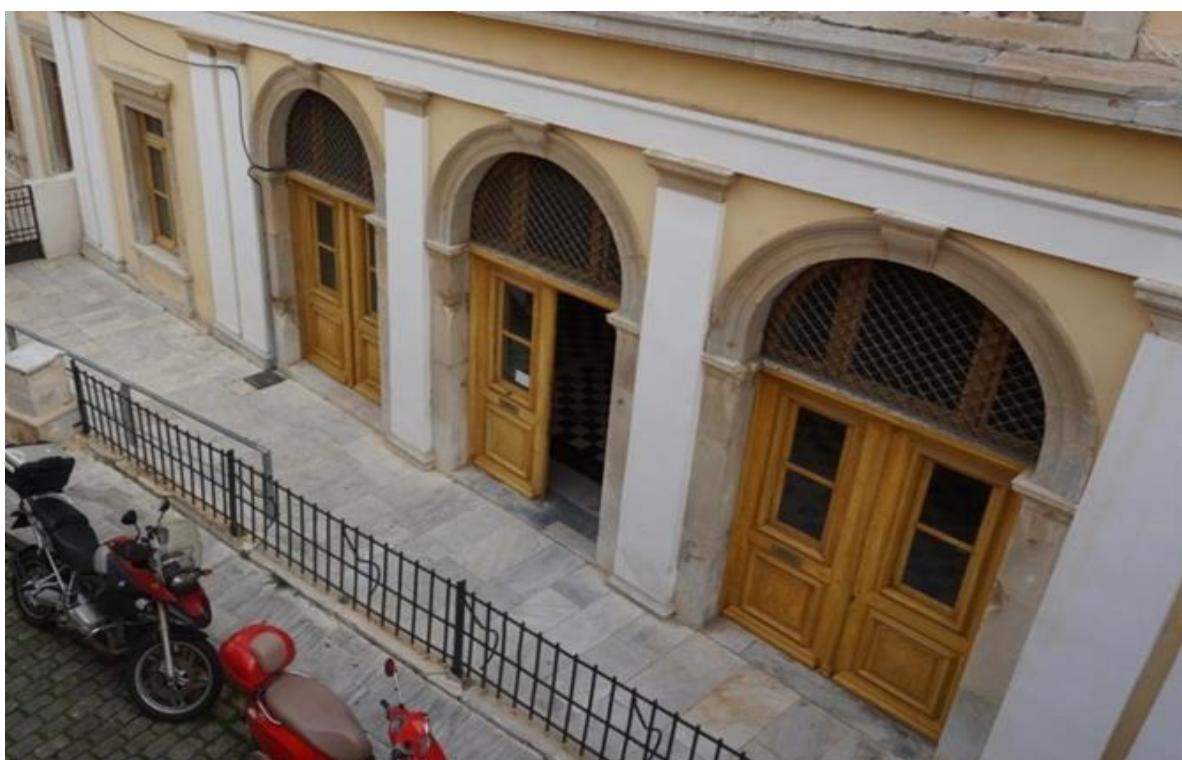
Εικ.51 : Βόρεια όψη-Θύρες εισόδου
