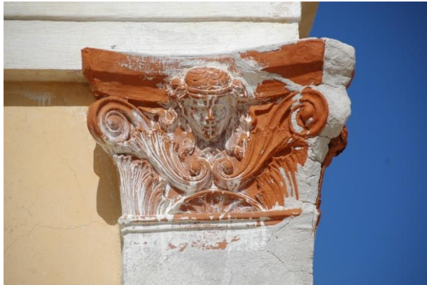
Εικ. 215 Συγκόλληση θραυσμάτων και κάλυψη απωλειών με τσιμεντοκονίαμα
