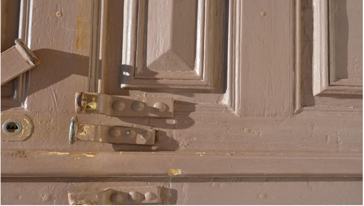
Εικ.44: Λεπτομέρεια θύρας- Νεότερη βαφή με λαδομπογιά
