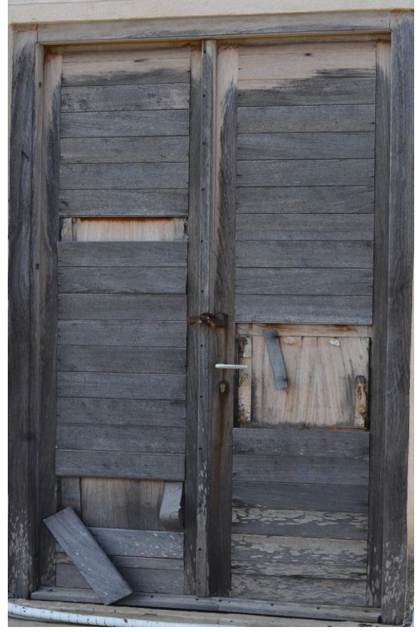
Εικ. 69, Εικ.70: Έλλειψη συντήρησης- Απώλεια χρωματικού στρώματος- Απώλεια τμημάτων-πύργοι
