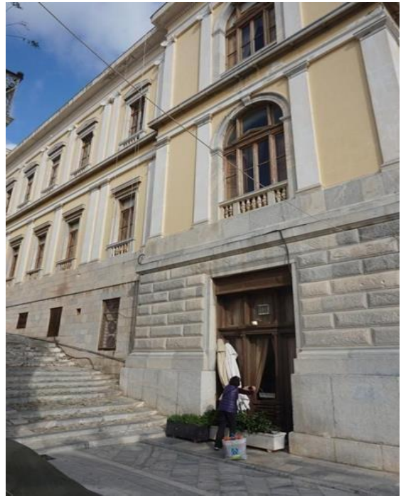
Εικ.54,Εικ.55 Διαφορετικοί τύποι κουφωμάτων στις όψεις του κτηρίου λόγω του αναγλύφου του χώρου
