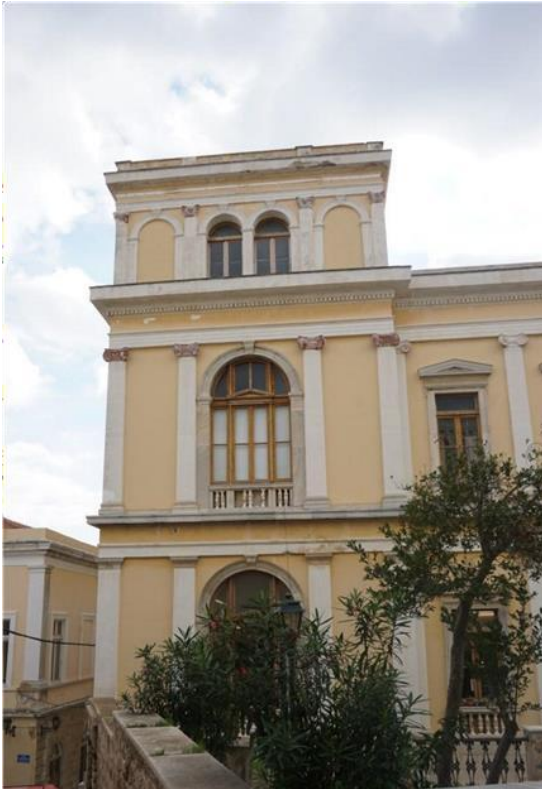
Εικ.26,27. Οι παραστάδες διαφορετικού ρυθμού ανά όροφο. Εμφανές είναι το υλικό κατασκευής των επικράνων και της μπαλουστράδας, λόγω απόλειας επιχρίσματος
