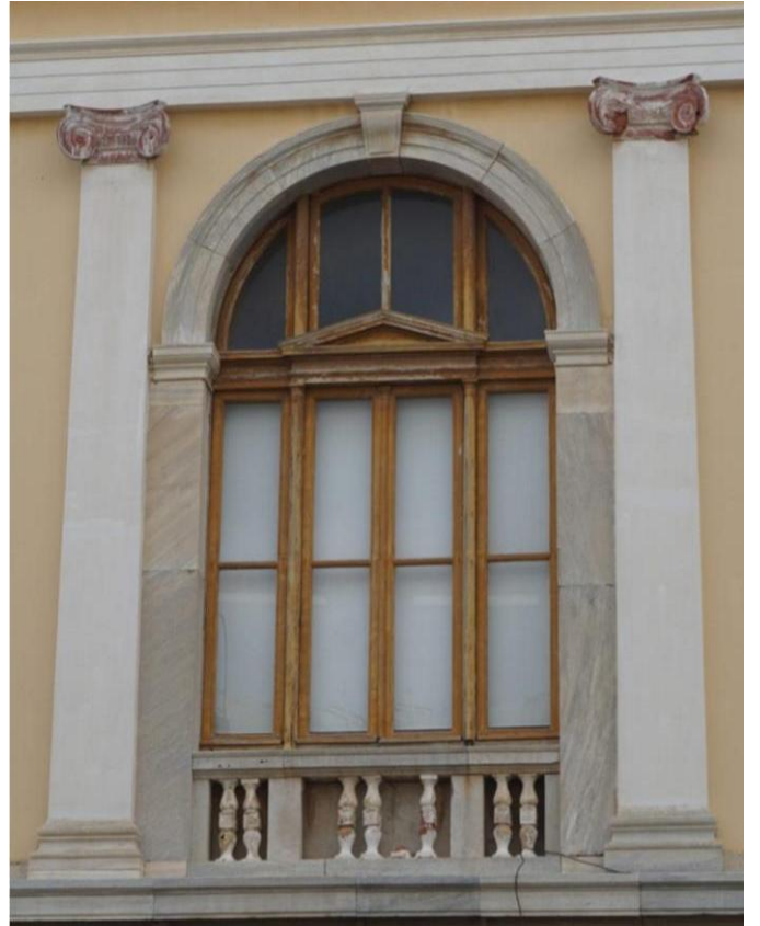
Εικ.45, Εικ.46 Κουφώματα βαμμένα με την τεχνική της απομίμησης ξύλου διαφορετικού τόνου
