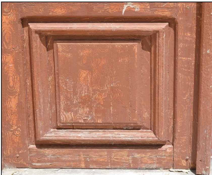
Εικ.43: Λεπτομέρεια θύρας- Νεότερη απομίμηση ξύλου
