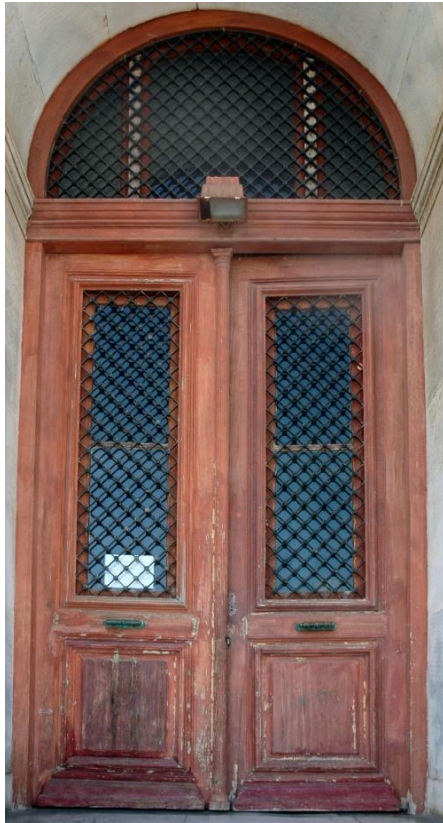
Εικ. 123 Η θύρα Θ1 της νότιας εισόδου
