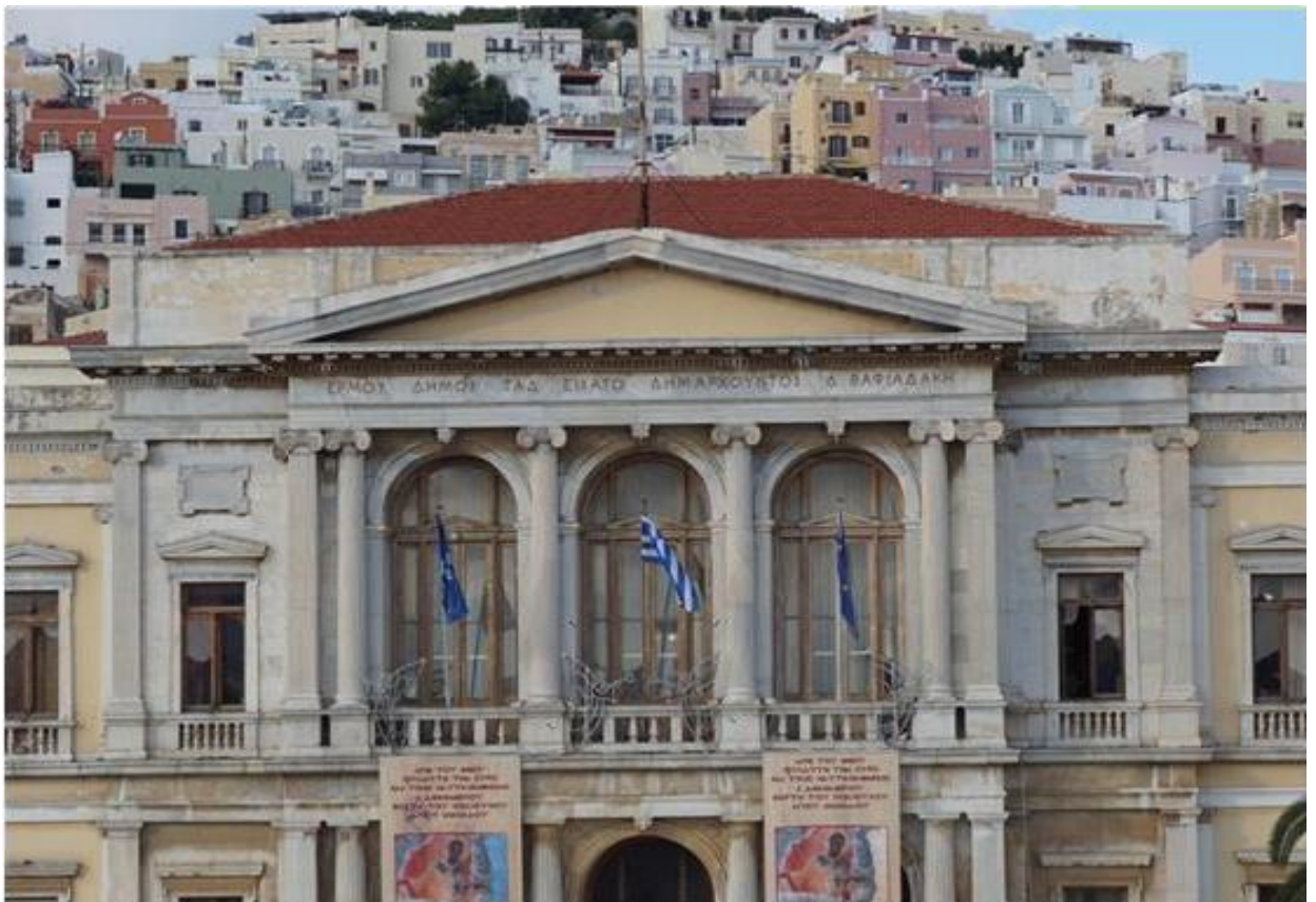
Εικ.28 Το κεντρικό τμήμα της πρόσοψης, διαμορφωμένο με στοιχεία ολόσωμου μαρμάρου.
