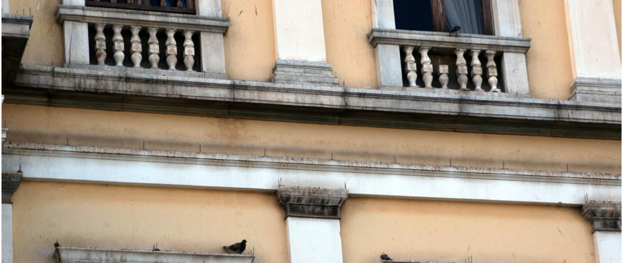
Εικ. 160 Βάση παραστάδας β' ορόφου και μαρμάρινο γείσο μεταξύ πρώτου και δεύτερου ορόφου
