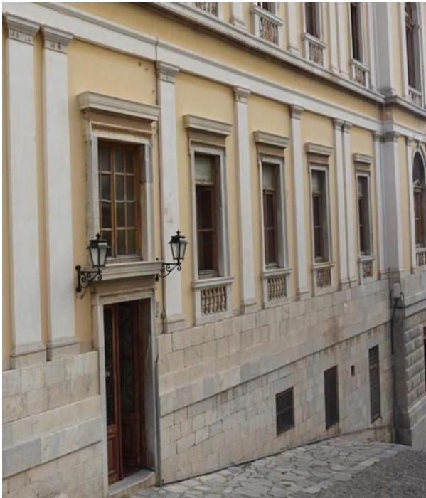
Εικ.54,Εικ.55 Διαφορετικοί τύποι κουφωμάτων στις όψεις του κτηρίου λόγω του αναγλύφου του χώρου
