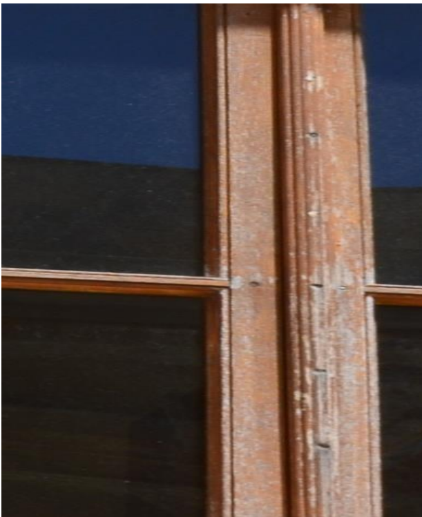
Εικ.60,Εικ.61: Απόλειες χρωματικού στρώματος
