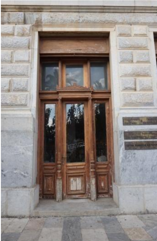
Εικ.45, Εικ.46 Κουφώματα βαμμένα με την τεχνική της απομίμησης ξύλου διαφορετικού τόνου
