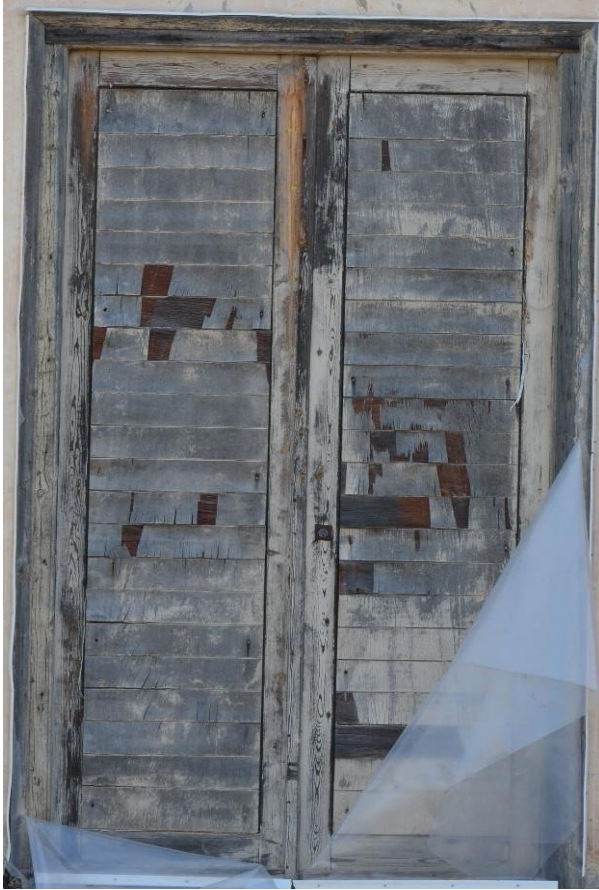
Εικ. 69, Εικ.70: Έλλειψη συντήρησης- Απώλεια χρωματικού στρώματος- Απώλεια τμημάτων-πύργοι
