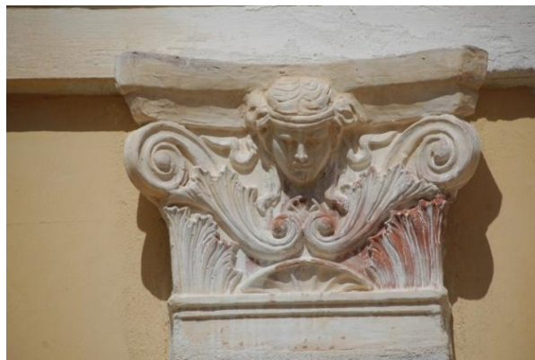
Εικ. 205 Επίκρανο του τρίτου ορόφου των πύργων σε άριστη κατάσταση διατήρησης
