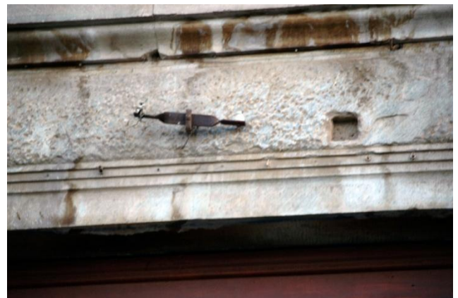
Εικ. 184 Διάνοιξη οπών για στήριξη κατασκευών και τηλεφωνικού δικτύου
