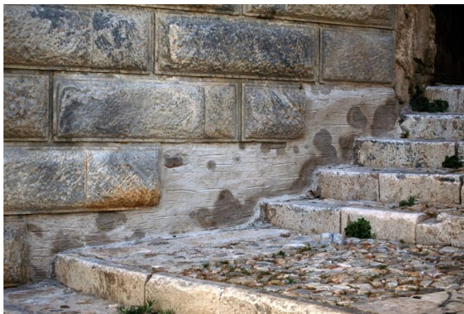
Εικ. 180 Συμπλήρωση απολειών με τσιμεντοκονίαμα
