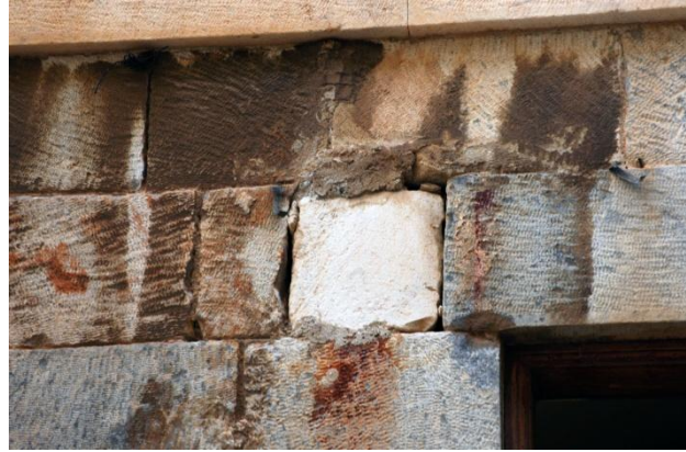
Εικ. 186 Σφράγιση διαμπερούς οπής
