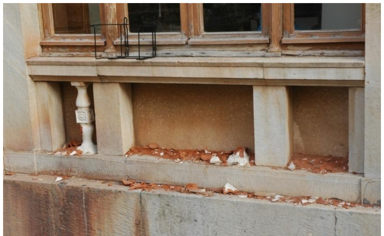
Εικ. 207 Μπαλουστράδα παραθύρου της βόρειας όψης. Αποτέλεσμα πιθανής ενέργειας βανδαλισμού
