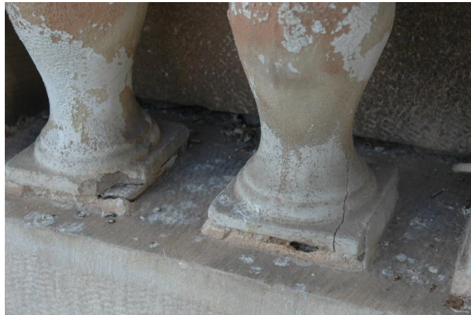
Εικ. 203 Βάση μπαλούστρου. Διακρίνεται η ξύλινη σανίδα και το κονίαμα κάλυψης αυτής
