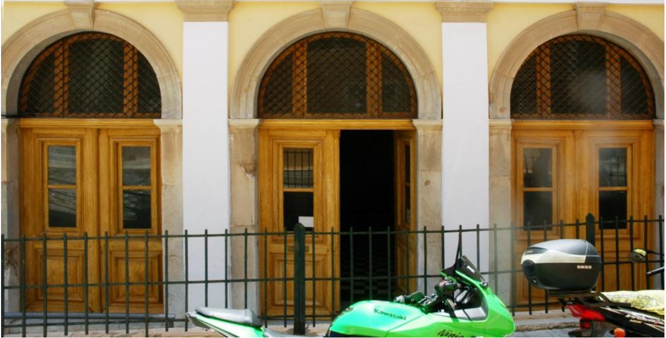
Εικ. 126 Οι θύρες Θ3 της βόρειας εισόδου
