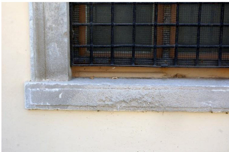
Εικ. 170 Υπολείμματα κονιαμάτων
