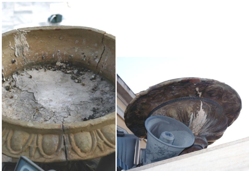
Εικ. 216 Ζαρντινιέρα, πλήρωση εσωτερικού με τσιμεντοκονίαμα, συγκράτηση με μεταλλικό στεφάνι
