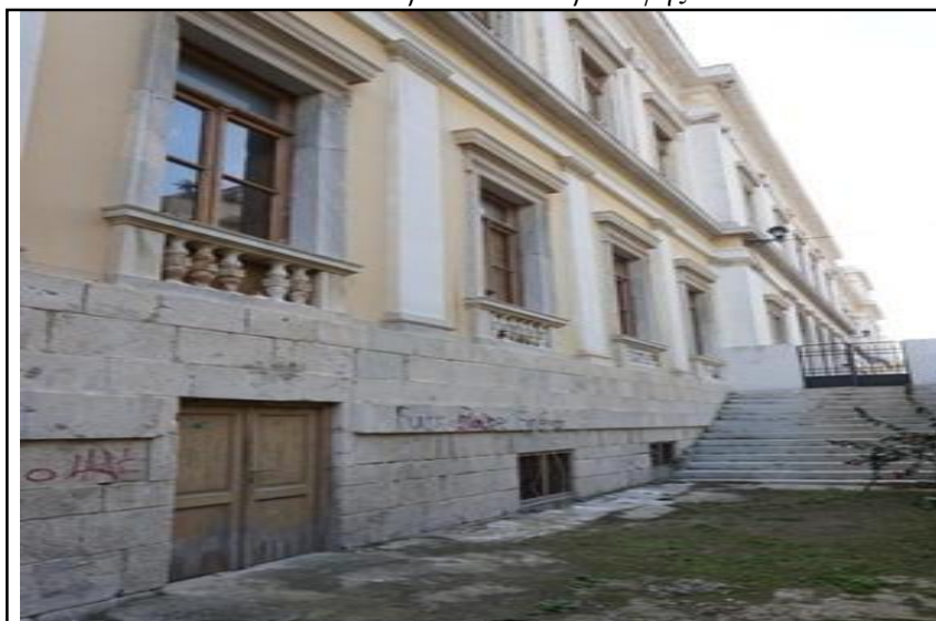
Εικ.48: Βόρεια όψη- Διαφορετικός τύπος κουφωμάτων στη βάση του κτηρίου
