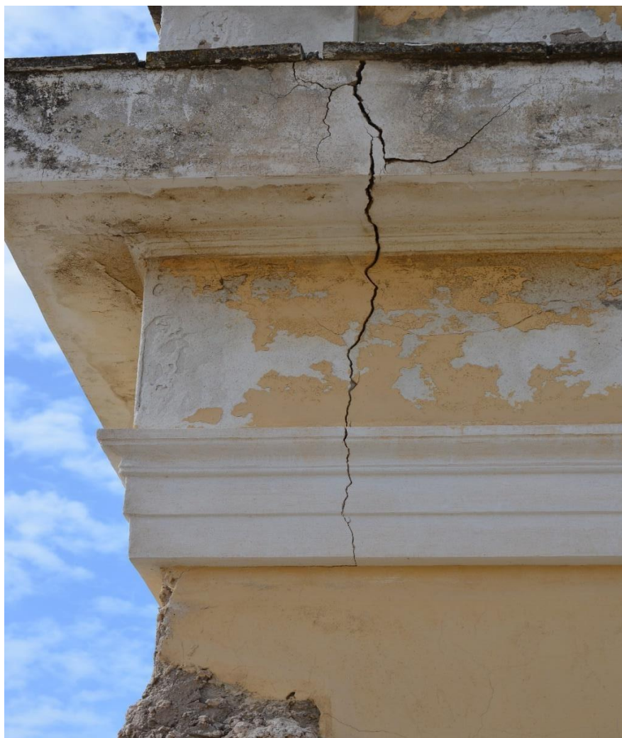
Εικ.84: Απώλεια κονιαμάτων-ρωγμές- αποκόλληση- βιολογική προσβολή - τσιμεντοκονιάματα
