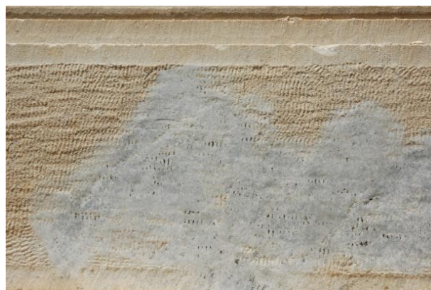
Εικ. 182 Απομείωση και λείανση της επιφάνειας μετά από «άστοχο» καθαρισμό
