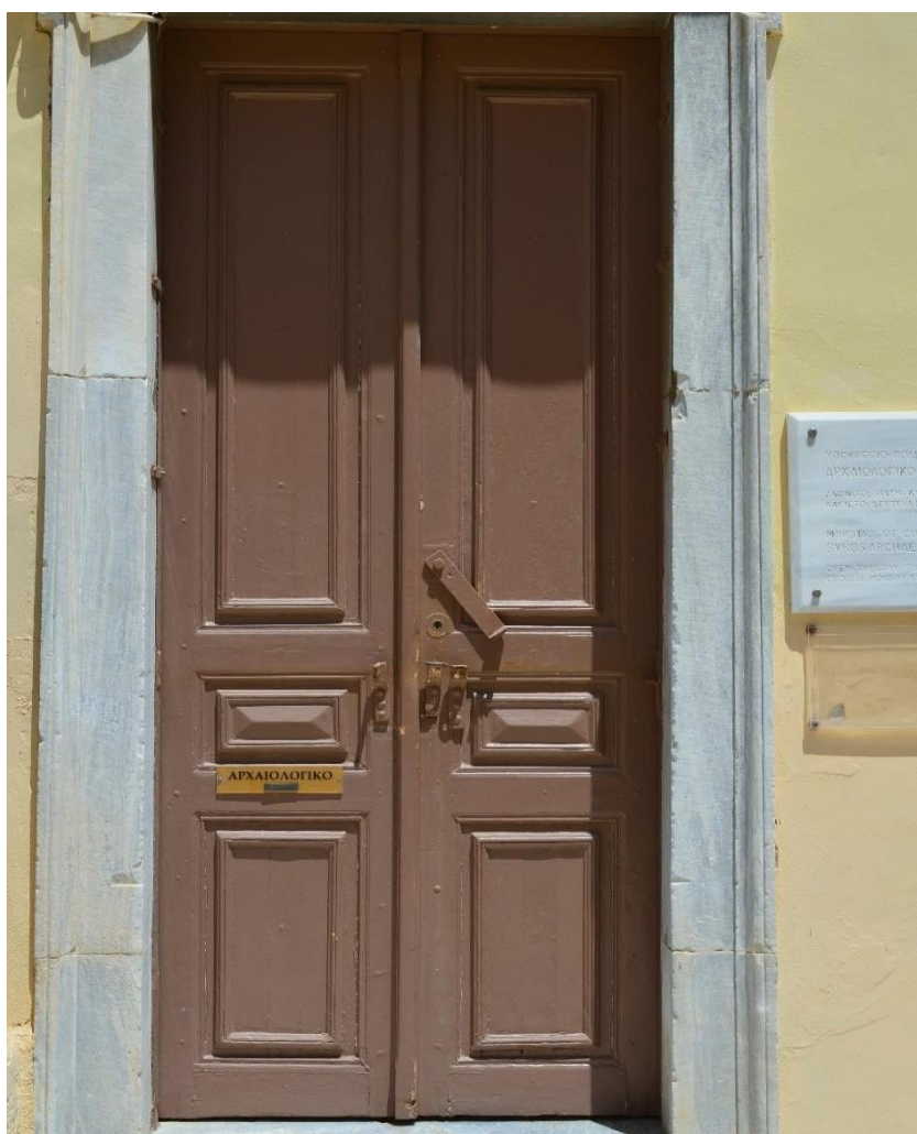
Εικ.68: Νεότερος ελαιοχρωματισμός θύρας Αρχαιολογικού
