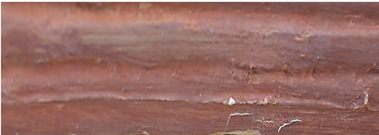
Εικ. 62: Επιχρωματισμός – νεότερα στρώματα βαφής στην κύρια είσοδο Νότιας όψης
