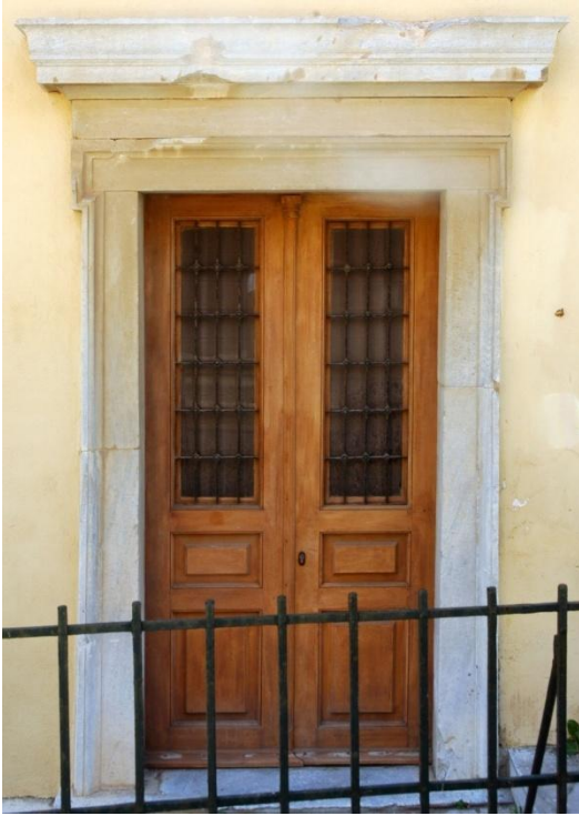
Εικ. 128 Η θύρα Θ4 της βόρειας όψης
