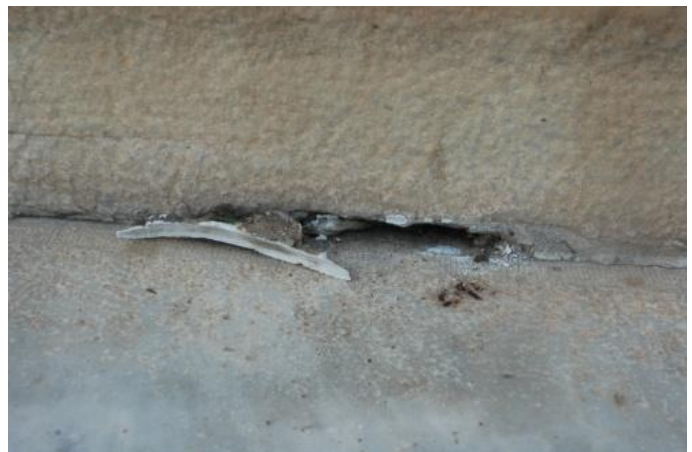
Εικ. 179 Πλήρωση αρμού με βιομηχανικού τύπου στόκο.
