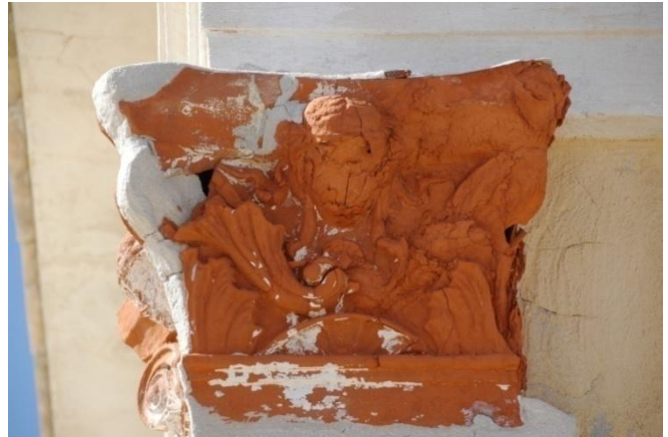
Εικ. 209 Έντονη αλλοίωση ανάγλυφου σε επίκρανο του γ' ορόφου των πύργων
