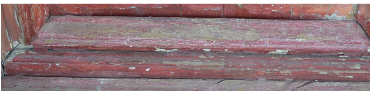
Εικ.64,Εικ.65,Εικ.66: Άνοιγμα αρμών στις θύρες Νότιας όψης
