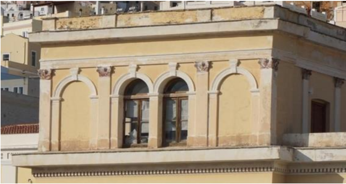
Εικ.86: Απώλεια κονιαμάτων- αποκόλληση- βιολογική προσβολή – αποχρωματισμοί
