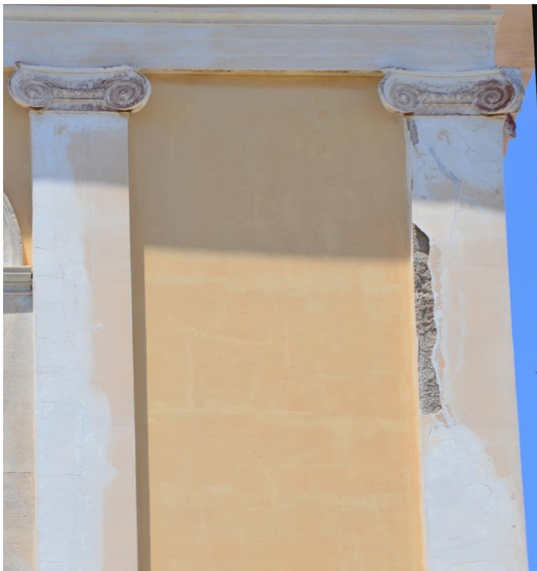
Εικ.84: Απώλεια κονιαμάτων- αποκόλληση- βιολογική προσβολή – νεότερα στοκαρίσματα
