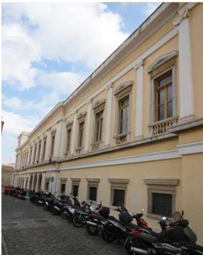
Εικ.24: Βόρεια όψη
