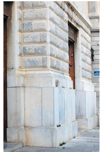
Εικ. 146 Νοτιοανατολικό τμήμα του ισογείου
