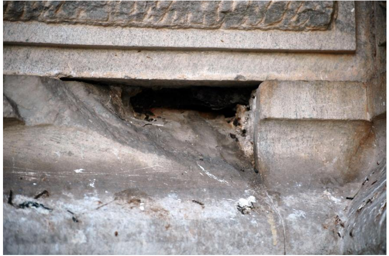
Εικ. 167 Απώλεια μαρμάρου από οξείδωση σιδερένιου συνδέσμου
