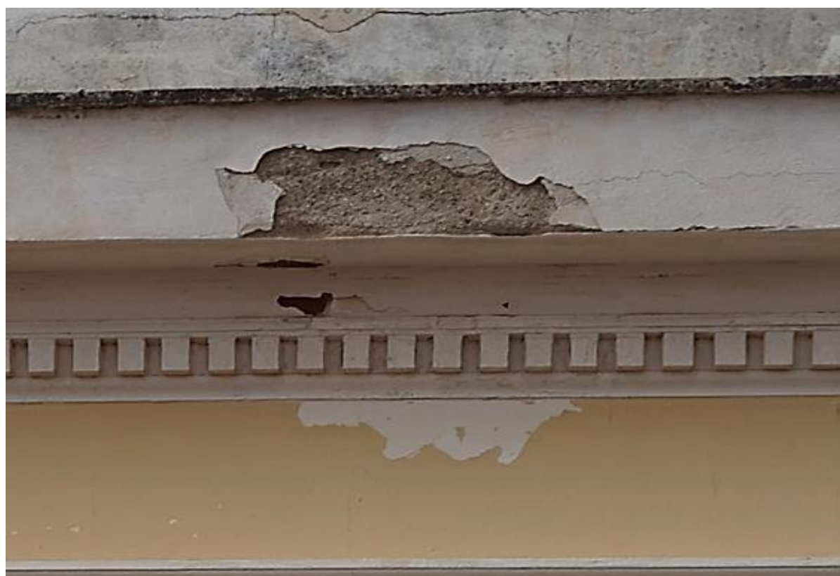
Εικ. 91: Αποκολλήσεις -λεκέδες υγρασίας- απώλεια επιχρισμάτων
