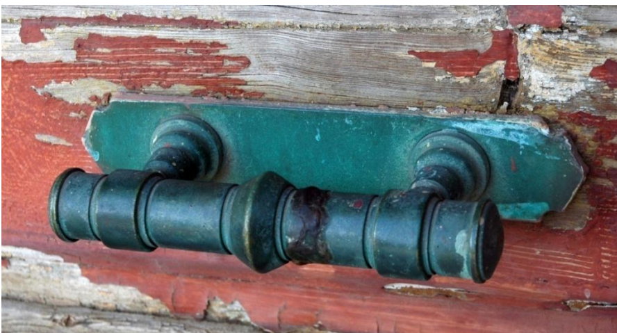
Εικ. 140 Συγκόλληση τμήματος χειρολαβής στη Θ1
