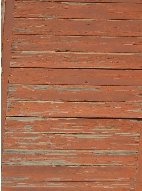
Εικ.71,Εικ.72: Λεπτομέρεια θυρών-ρηγμάτωση και απώλεια χρωματικού στρώματος-πύργοι
